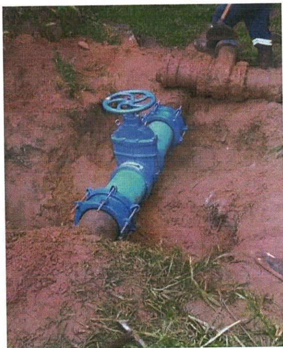
Substituição de registro DN 250 mm
