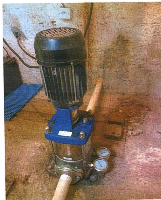
Implantação de gerador de energia hidráulico
